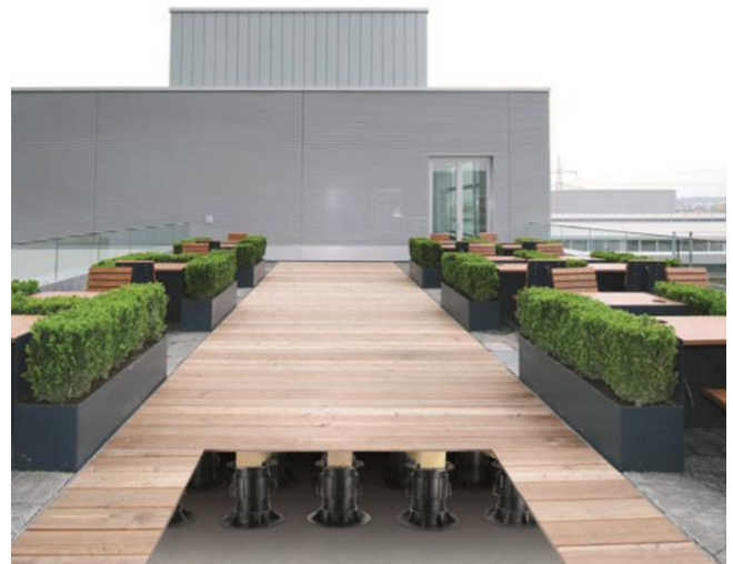
Abb. 16: EnBW Dachterrasse, Kombination Holz & Stein, Unterkonstruktion PLV50/75 mit ZSt65/100, 135-170 mm Höhenausgleich.
