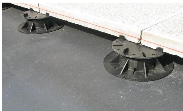
Abb. 24: PLV50/75, Beginn einer Plattenverlegung am Rand mittels Lotfaden.
