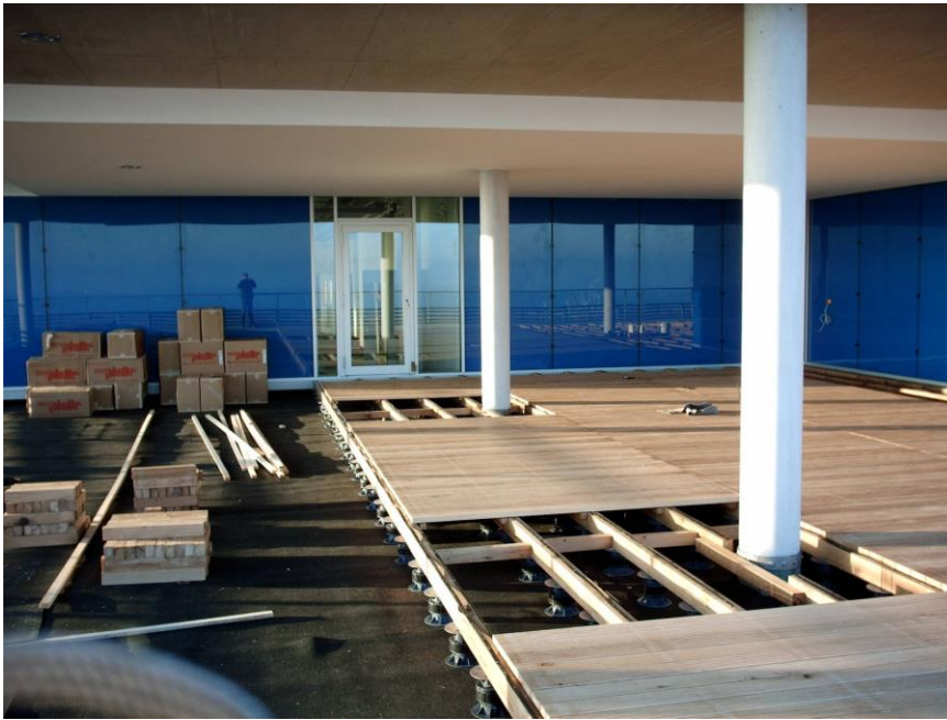
Abb. 13: Starre Plattenlager PP155/15, PP155/45 gestapelt, kombiniert mit dem höhenverstellbaren PLV50/75, Bauvorhaben MPI Tübingen.
