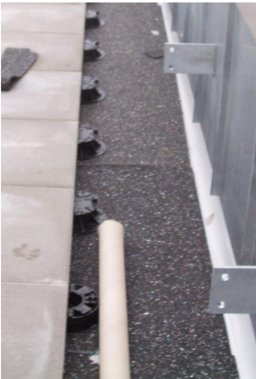
Abb. 19: PLV50/75 kombiniert mit AS15/3 Projekt „euro-gate“ Hamburg.
