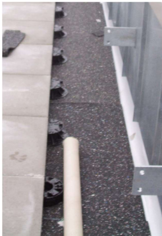
Abb. 19: PLV50/75 kombiniert mit AS15/3 Projekt „euro-gate“ Hamburg.
