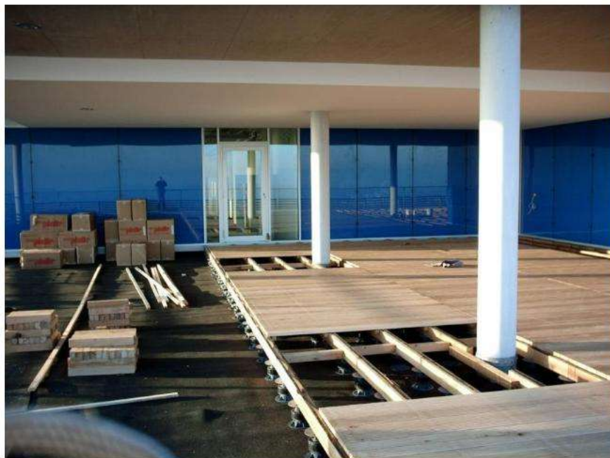
Abb. 13: Starre Plattenlager PP155/15, PP155/45 gestapelt, kombiniert mit dem höhenverstellbaren PLV50/75, Bauvorhaben MPI Tübingen.
