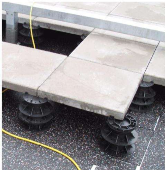
Abb. 17: Höhenverstellbares PLV50/75 mit starren Stelzlagern PP155/15, Bauvorhaben „euro-gate“ Hamburg.
