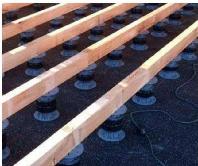
Abb. 15: 2 starre Plattenlager PP155/45 gestapelt, kombiniert mit 2 PLV50/75, Bauvorhaben MPI Tübingen.
